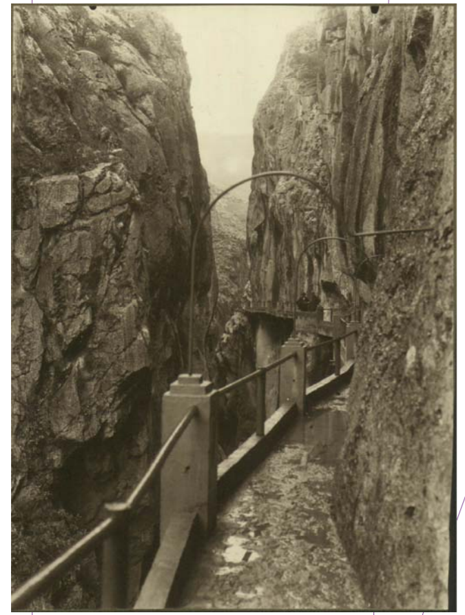
FOTO 3 DETALLE DEL TRAMO DE PASARELA EN EL INICIO DEL DESFILADERO
