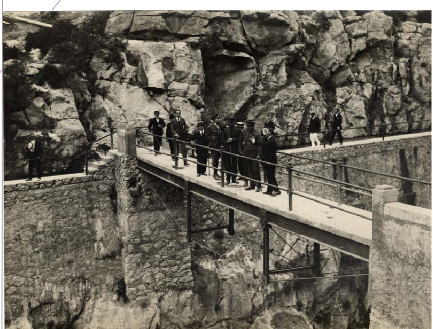
FOTO 2 ESTADO ORIGINAL DEL PUENTECILLO DEL REY
