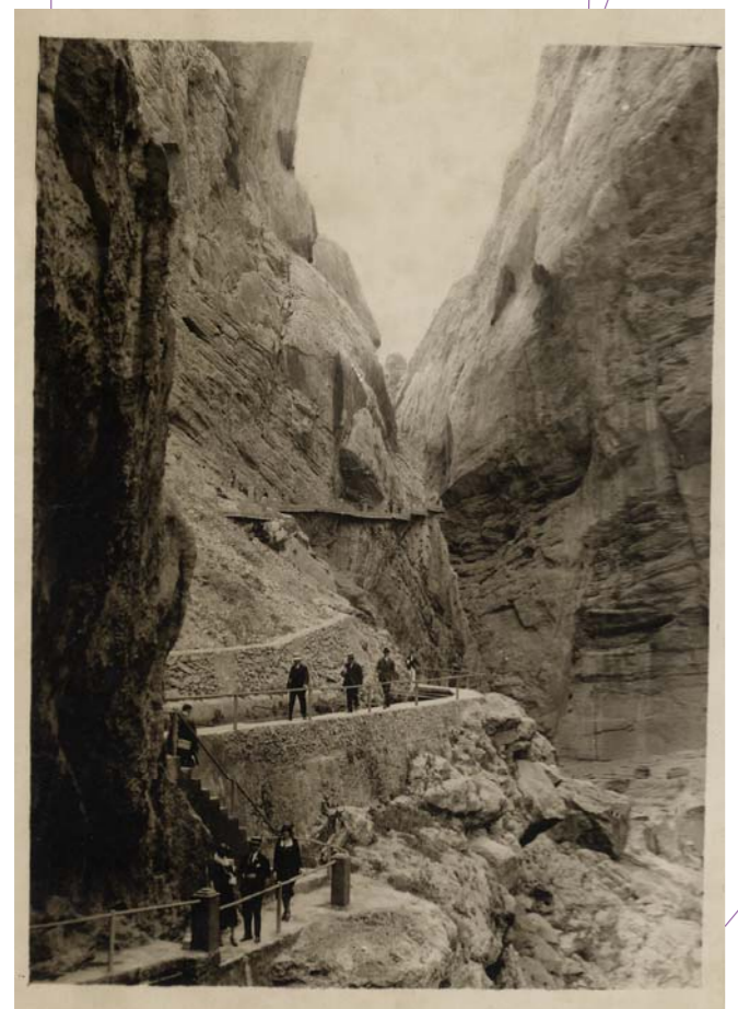
FOTO 4 IMAGEN ORIGINAL DEL CAMINO A LA ALTURA DEL PRIMER TRAMO DE CANAL A CIELO ABIERTO
